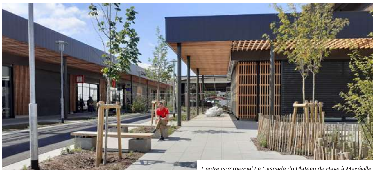
Centre commercial La Cascade du Plateau de Haye à Maxéville
