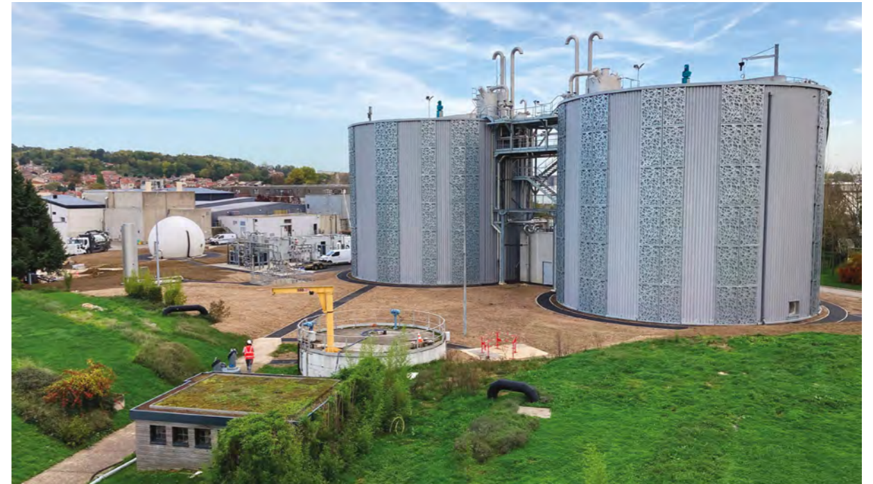
Les digesteurs de la station d'épuration
