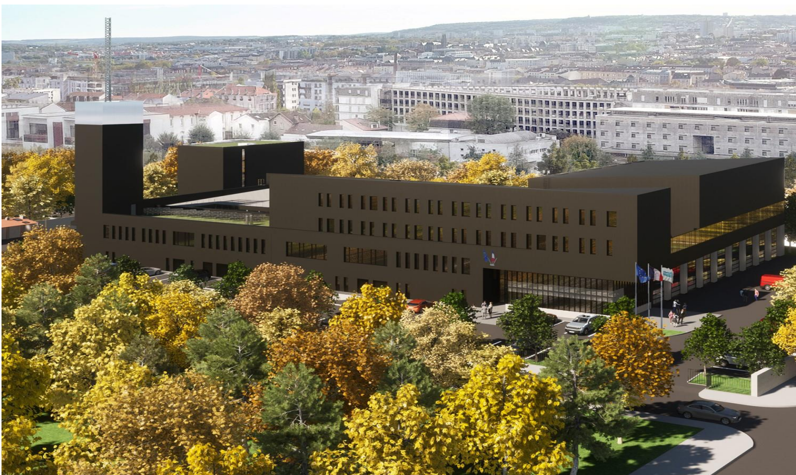
Construction d'un Centre de Service d'Incendie et de Secours à Nancy
